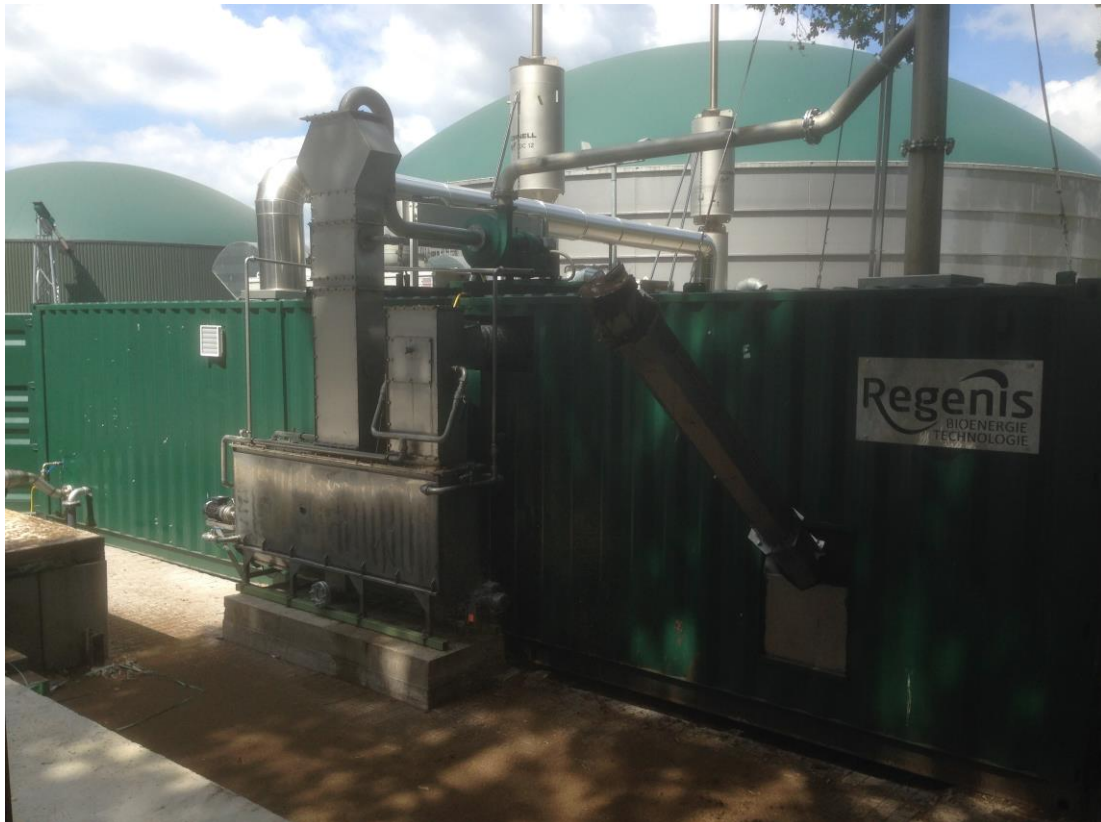
Abb. 1: Außenansicht der Trocknungsanlage Regenis GT – verbaut in einem 40'-Container
